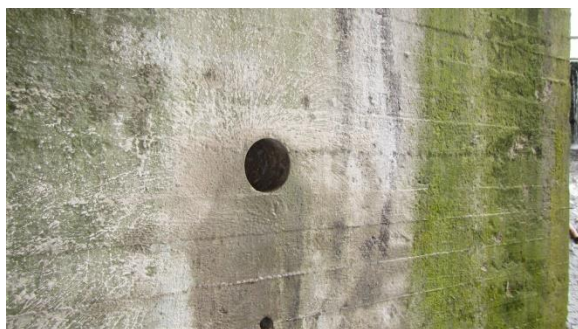
Foto 4.3.1 Pohled na zkušební místo provedeného jádrového vývrtu z pravé opěry (OP2)
